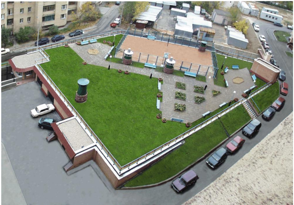
Пример подземной парковки с эксплуатируемой кровлей
