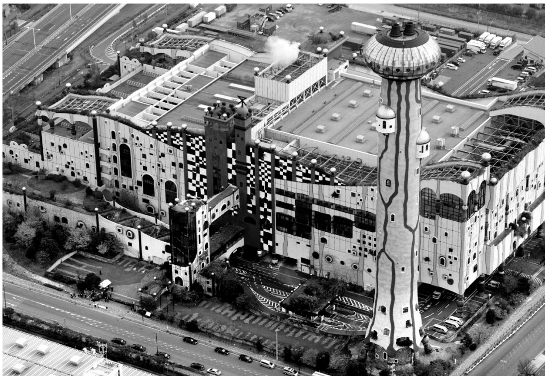
Рисунок 1 – Мусоросжигательный завод Шпиттелау
